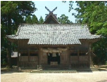
22. Oratory building, Rokusho Jinja.
